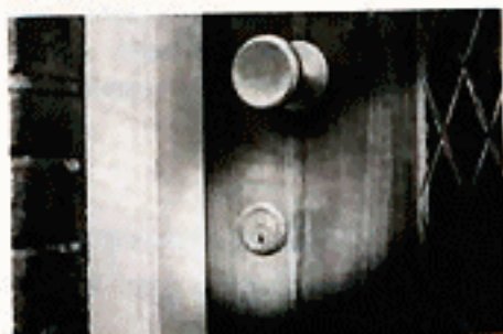
Sleutelgatverlichting. Lampje in schijnwerper van een fiets
